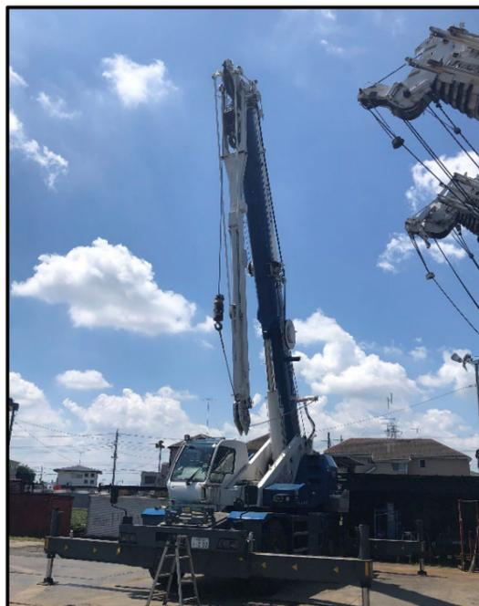
⑥ 補助ロープを取り外し、ジブ先端に過巻防止装置を取付ける。
